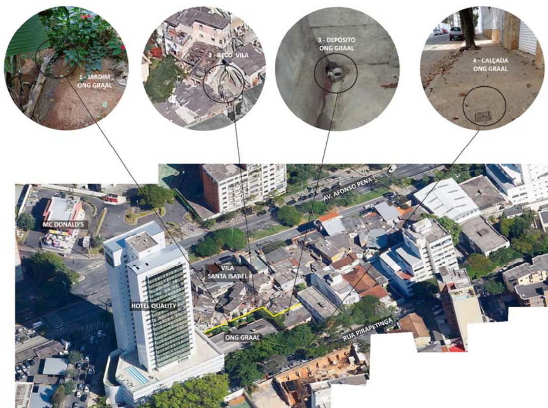
Figura 3 – Pontos de afloramento das águas residuais na ONG Graal e na Vila Santa Isabel
